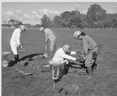
▲ドリルで穴を開け砂利詰め作業を行う職員
