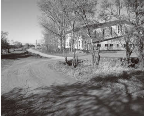
安全対策が望まれる屋内グラウンド周辺
