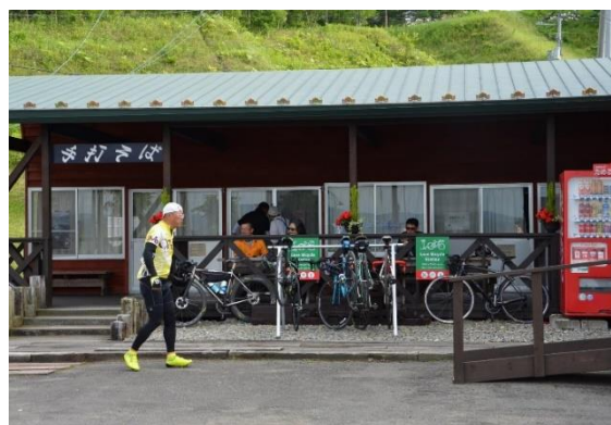
図 3-6 休憩施設整備事例 (トカプチ 400)
