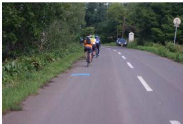
図 3-7 自転車通行位置を示す路面表示設置事例 (石狩市)
