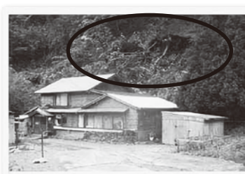
がけが崩れた！
