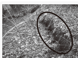
地面に亀裂が！
