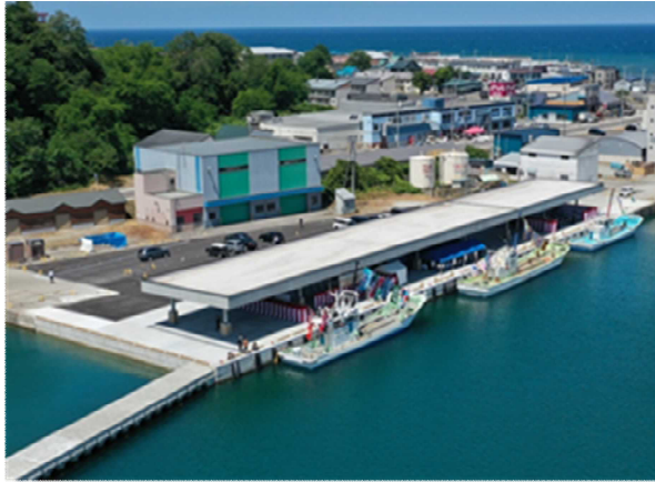
令和3年完成 増毛港の屋根付き岸壁
