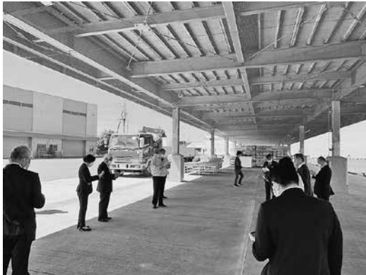
～ 衛生管理の強化を目的に建設された屋根付き岸壁 ～
