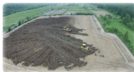
(表土戻し作業)
