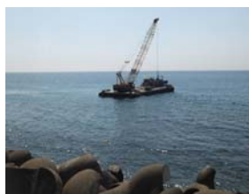
雄冬岬漁場 (令和3年施工)
