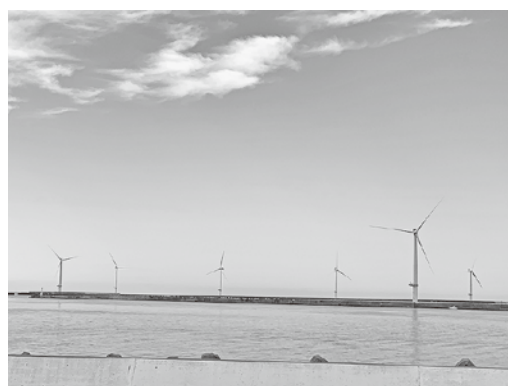
～ 秋田港湾区域内に設置された洋上風力発電～
