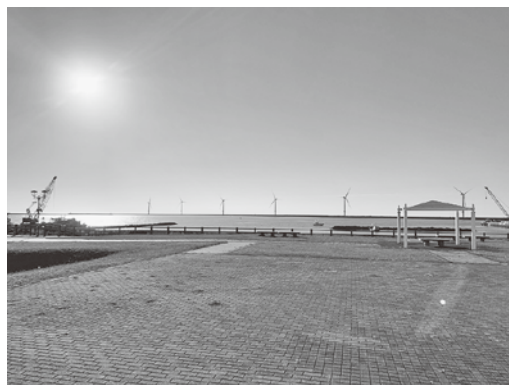
～ 能代港には20基の大型風力発電が並ぶ～
