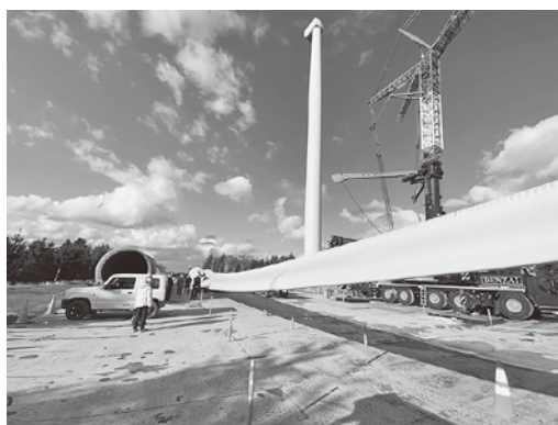
～ 特殊なクレーン車でブレードを装着させる ～
