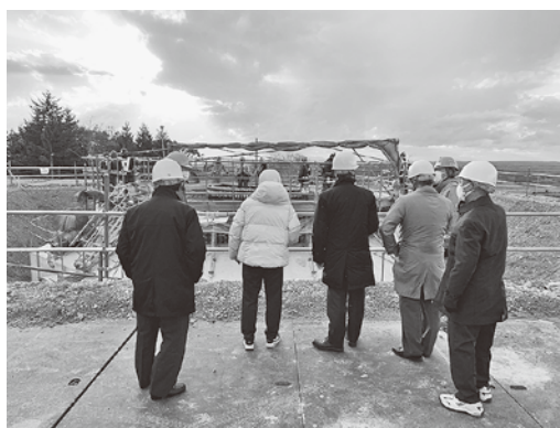
～ 工事初期段階となる基礎工事作業工程も確認 ～
