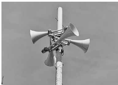
～災害時に屋外でも放送が聞けるように設置されている拡声子局～
