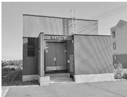
～ 電気設備更新工事を予定している増毛ポンプ場 ～
