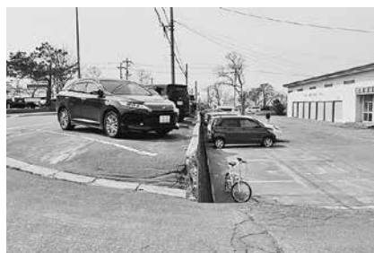
～ 令和3年度は弁天町3丁目通線道路擁壁改良工事を実施～
