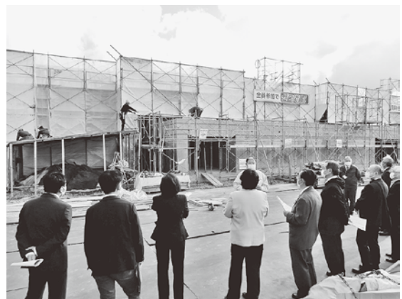
～ 順調に工事が進む町営住宅建設工事 ～
