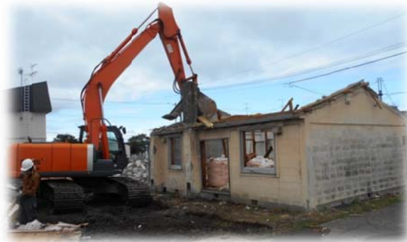
老朽化した町営住宅の解体
