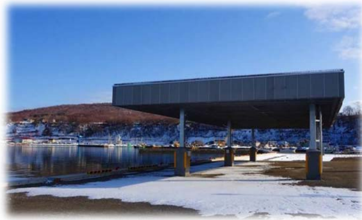
増毛港屋根付き岸壁
