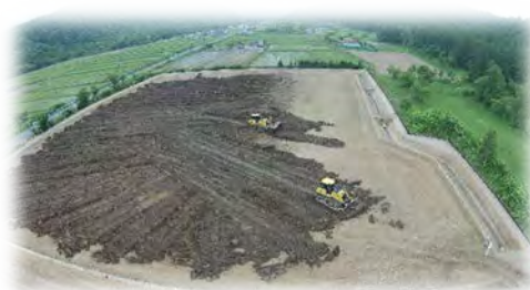
(表土戻し作業)
