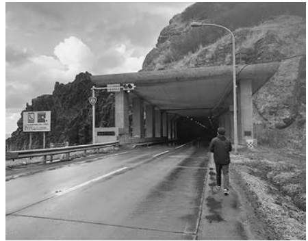
▲発生場所：岩尾 黒岩トンネル
