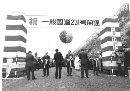
昭和56年11月：国道231号開通式
