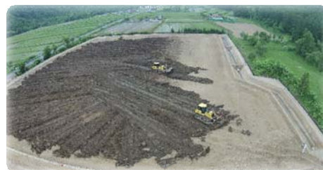
(表土戻し作業)
